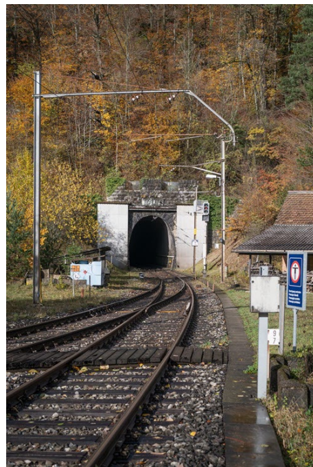
Entrée du tunnel à Oberdorf: à partir du 4 mars, le tunnel du Weissenstein sera fermé au trafic ferroviaire.
